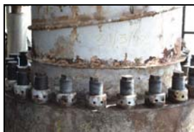
Top dome flange
